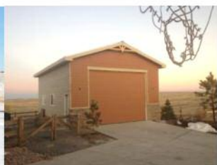
24x32 Hardi-Plank Siding - Parker
